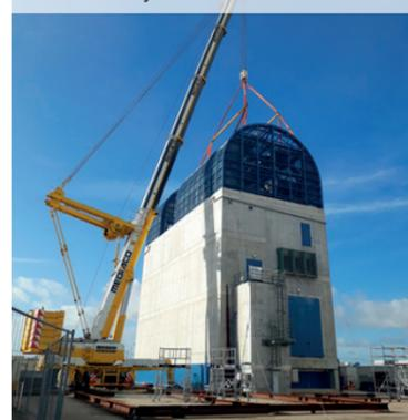
Un chantier de grande ampleur s'est achevé pour les équipes de la centrale de Belleville-sur-Loire. Les 29 et 30 juin 2020, les deux Diesels d'ultime secours (DUS) raccordés et connectés à leurs unités de production respectives ont été mis en exploitation.
